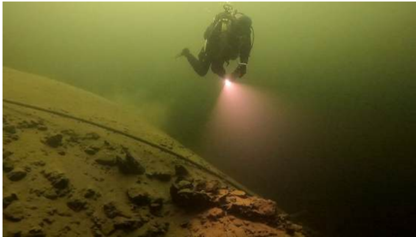
Abb. 14: Abfall des flachen Schlammplateaus und Beginn der kleinen Steilwand in 9 m Tiefe. Ansaugschlauch für den Betrieb der Wärmepumpen (5 cm Durchmesser, ummantelt mit einer Schutzhülle). Foto: Ch. Macherhammer.
